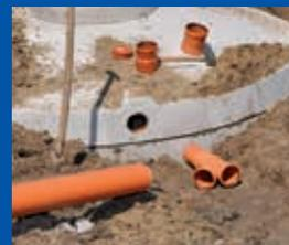
**Verfüllen und einfaches Anschließen** der Versorgungsleitungen durch serienmäßig eingesetzte KG-Muffen.
