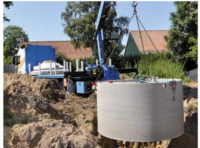
Das Bild zeigt eines unserer Lieferfahrzeuge beim Einsetzen einer Komplettanlage. Gerne setzen wir auf Anweisung Ihres Fachunternehmers die Kleinkläranlage in die vorbereitete Baugrube ein.
